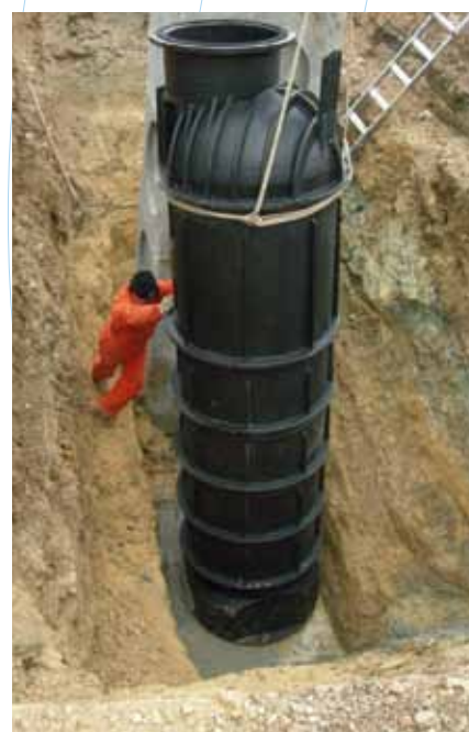
Una fase dell'interramento del grande cilindro in polietilene che contiene il sismometro della stazione ED06.
